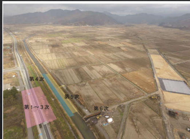
図1 調査区と大谷地を縦断する高速道路の盛土工事(南西から)
