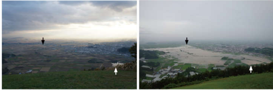
図 64 平時と水害時の大谷地全景（北東から） 黒矢印が押出遺跡、白矢印が白竜湖の位置。平成 26 年 7 月の大雨により大谷地一帯が冠水した（右）。高低差が少ないため、一帯が水に覆われてしまった。前年に続き二年連続の水害であった。
