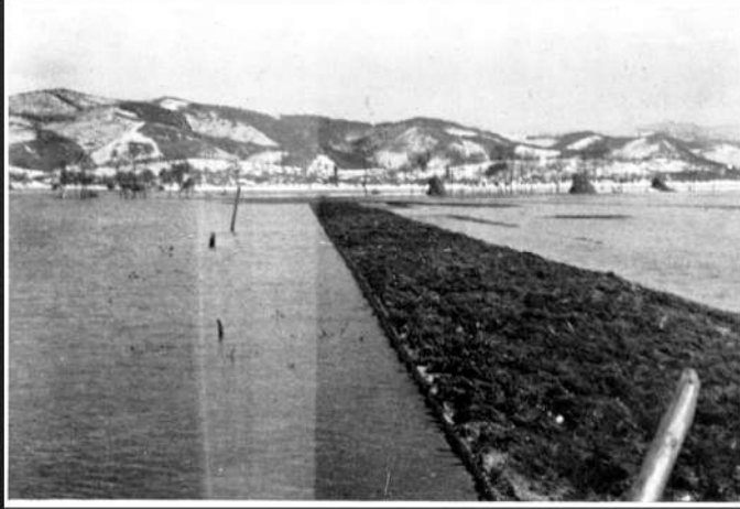
⑥ 試験施工完成のもので、雪がすっかりとけて、周囲一面タン水の中にくっきりと護岸だけが浮き出している。
